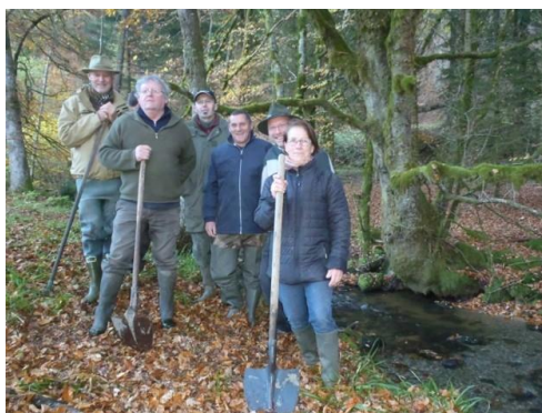
L'équipe de la truite des Monédières, lors de travaux de réalisation de frayères.
